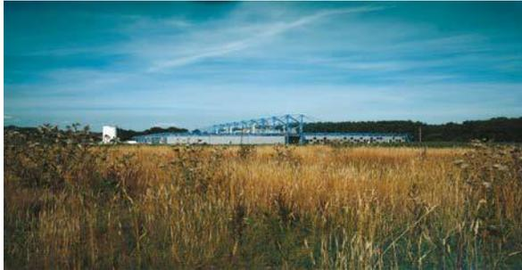
**Figure 12:** l'usine Inmos de Microprocesseur , à New port, South Wales, 1982; Architectes Richard Rogers associés; Anthony Hunt ingénieurs en structure. L'aspect général et l'apparence de ce bâtiment ont été fortement influencés par la exigences de la structure exposée. La forme de cette dernière a été déterminée par les exigences de planification de l'espace intérieur.
