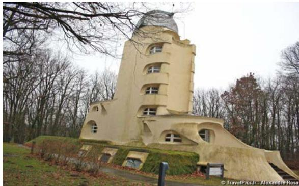
**Figure 07:** Les exigences structurelles ont peu d'influence sur la forme extérieure de ce bâtiment, bien qu'elles aient une influence sur l'aménagement intérieur. Étonnamment, il a été construit en maçonnerie porteuse.
