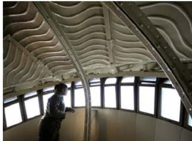
**Figure04:** La surface mince extérieure de la Statue de la Liberté située dans le port de New York, aux États-Unis, est soutenue par une structure triangulaire. L'influence des considérations structurelles sur la version finale de la forme était **minime**.
