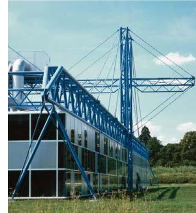
**Figure 13:** l'usine Inmos de Microprocesseur , à New port, South Wales, 1982; Architectes Richard Rogers associés; Anthony Hunt ingénieurs en structure. L'aspect général et l'apparence de ce bâtiment ont été fortement influencés par la exigences de la structure exposée. La forme de cette dernière a été déterminée par les exigences de planification de l'espace intérieur.
