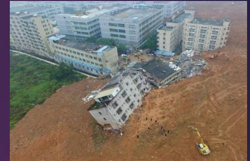
Glissement de terrain.
