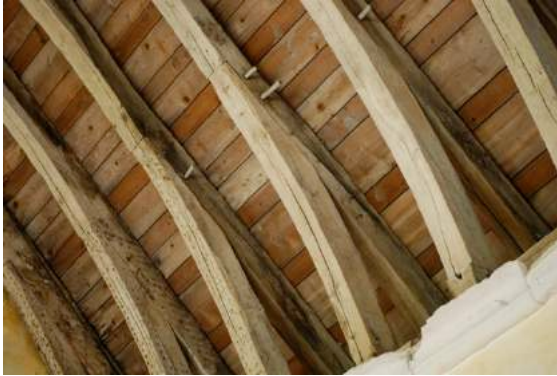
La structure de toit en bois du dortoir de l'abbaye de Fontenay est une solution hautement ordonnée et efficace.
