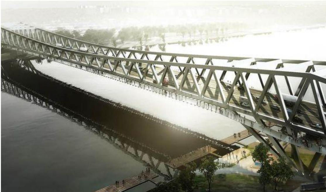
**La portée du pont, est de 480 mètres de pile à pile, à Ningbo (Chine)**
