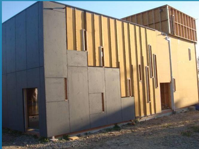
Bardage en panneaux composites avec isolant.
