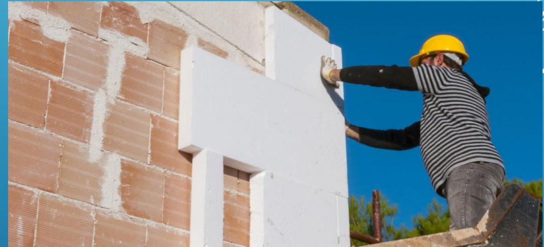
Isolation par l'extérieur avec des panneaux de Polystyrène.
