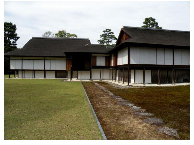
L'un des grands succès de l'architecture japonaise a été l'utilisation d'un système modulaire basé sur l'espacement entre les colonnes. À partir de cette proportion initiale, toutes les autres relations proportionnelles des éléments de structure ont été déterminées - poutres, chevrons et autres éléments de support de la structure.
