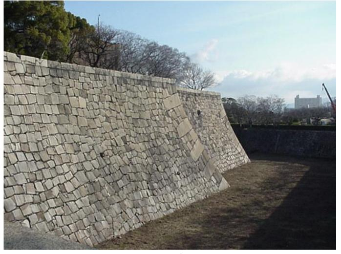
Le mur de soutènement en pierre d'un château japonais apporte une belle solution à un problème fonctionnel . La courbe du mur est de forme primitive et de concept simple. L'attention au détail dans la pierre reflète la sensibilité japonaise à la relation entre la beauté et l'intégrité structurale.
