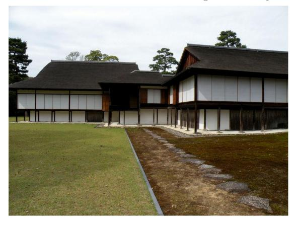
Le squelette en bois permet une séparation de la structure et de l'enveloppe. Des colonnes régulièrement espacées soutiennent le toit. Les écrans **shoji** en papier de riz fournissent une enveloppe ou une glissière pour permettre la ventilation, l'intimité ou le changement de vue. Le raffinement et l'élégance de cette architecture ont été réalisés par un artisanat exquis, de belles proportions et des matériaux de la plus haute qualité.
