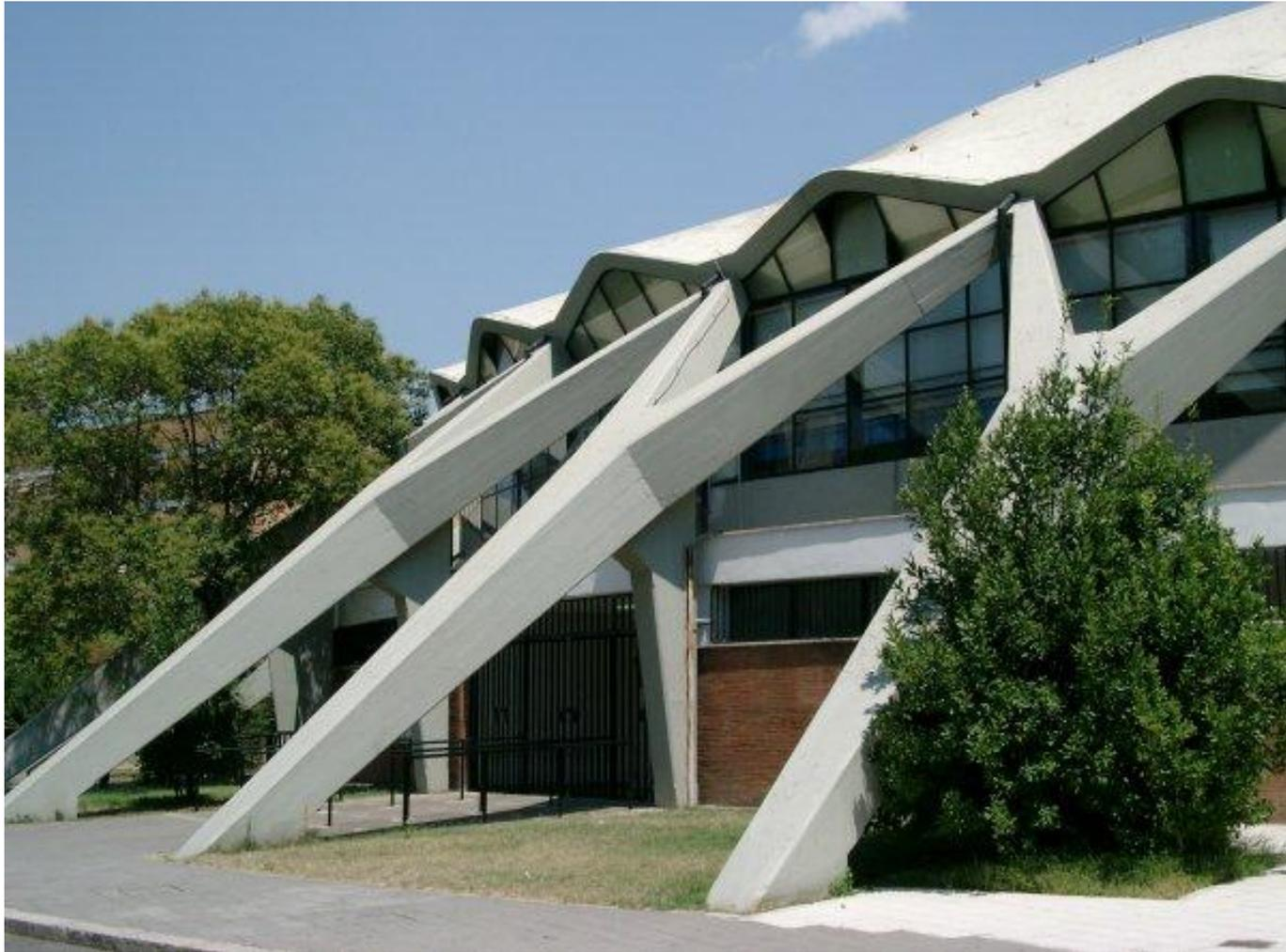
Le dôme de La face extérieure du dôme est construite avec une seule poutre circulaire. Les 36 poutres ont chacune trois éléments en éventail qui traversent la poutre circulaire du dôme.
