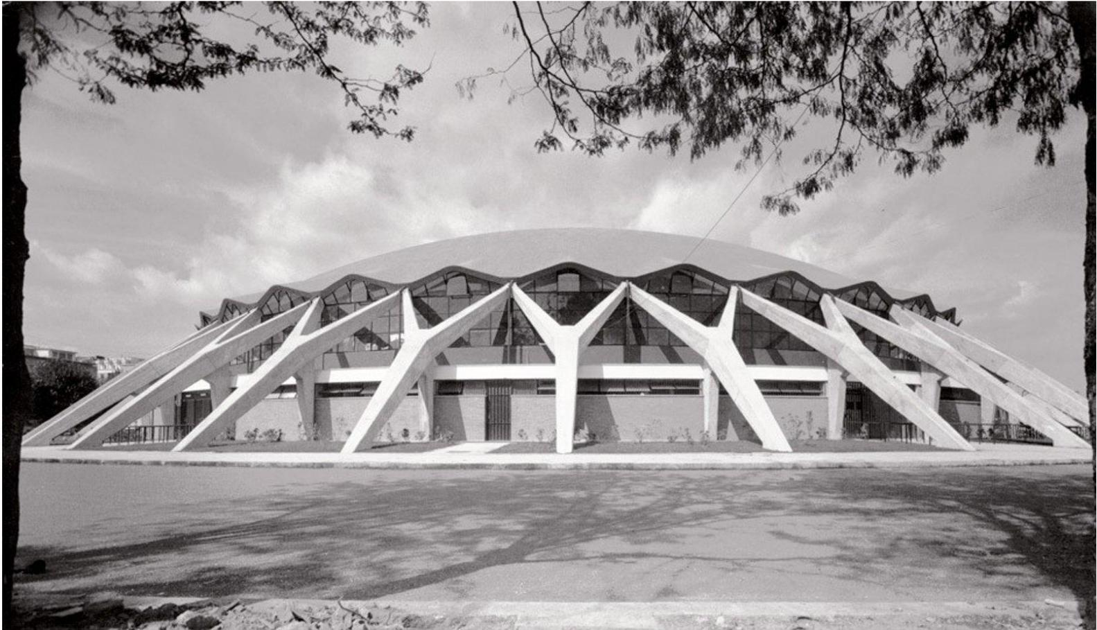
Le dôme de forme carapace est soutenu sur les bords par un cercle de 36 poutres ayant chacune la forme d'un «Y». Elles sont inclinées d'une manière tangente avec une poussée axiale pour éviter les flexions qui portent sur une autre poutre circulaire en béton armé de 2,5 m d'épaisseur et de 8,15 m de diamètre. La face extérieure du dôme est construite avec une seule poutre circulaire. Les 36 poutres ont chacune trois éléments en éventail qui traversent la poutre circulaire du dôme.
