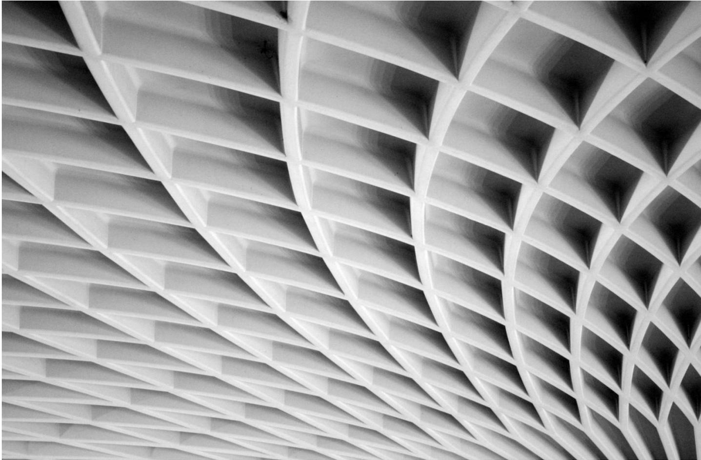
Tous ces éléments ont été préfabriqués avec l'aide d'une grue au centre du dôme, elle prenait les moules à brique avec le mortier de ciment et les mettaient en place. La construction et la mise en place du dôme ont pris 30 jours.
