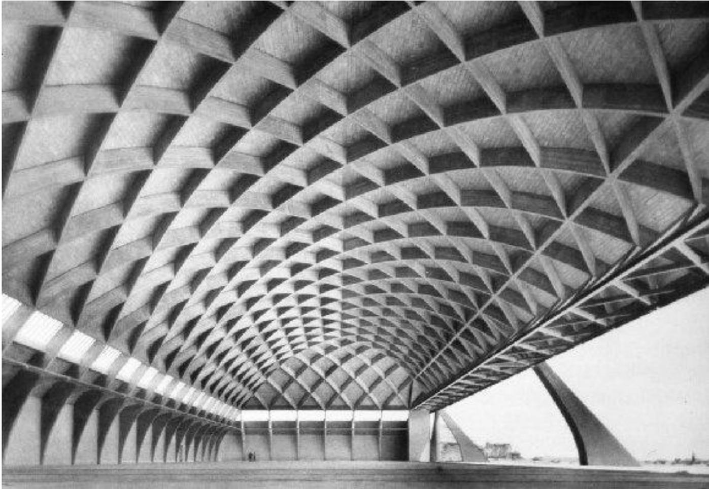
Les restrictions sur l'acier imposées par la guerre obligèrent Nervi à utiliser du béton et il répondit par un concept audacieux. Dans ses hangars d'avions de 1940, il développa un système de petites unités préfabriquées liées par du béton coulé sur place. Ces unités pouvaient être érigées avec de petites grues facilement disponibles.
