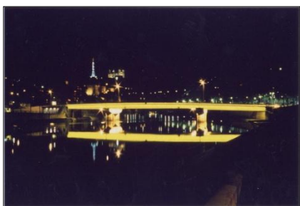
Pont Clemenceau – Lyon
